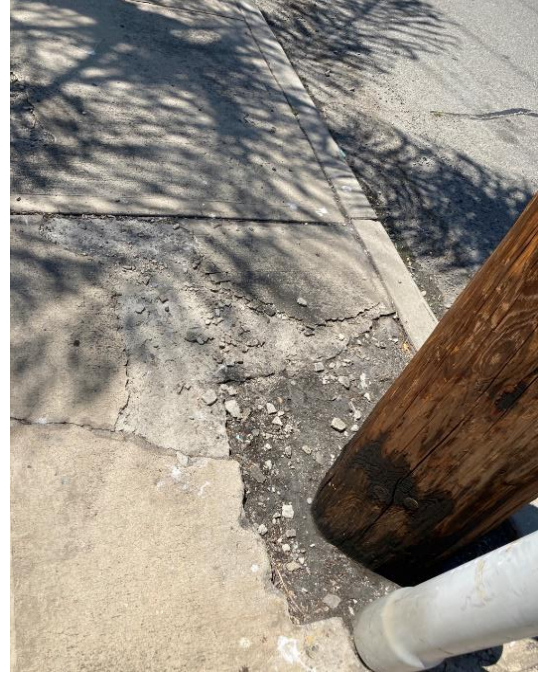
Spalling
