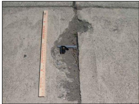
Spalling
